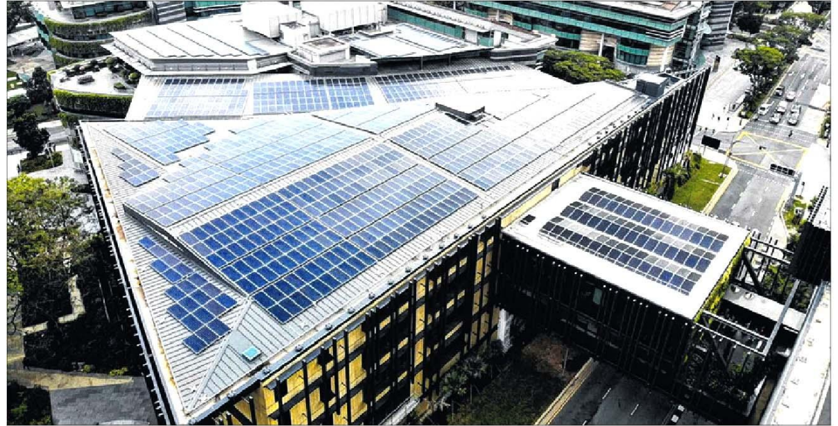
新加坡管理大学校园新多用途教学楼的屋顶，安装了420个太阳能板，可满足大楼一年12%的能源需求。（新大提供）
